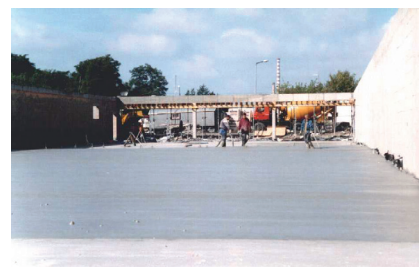
Rys. 1. Wykonanie posadzki, Lidl Łódź [7]
