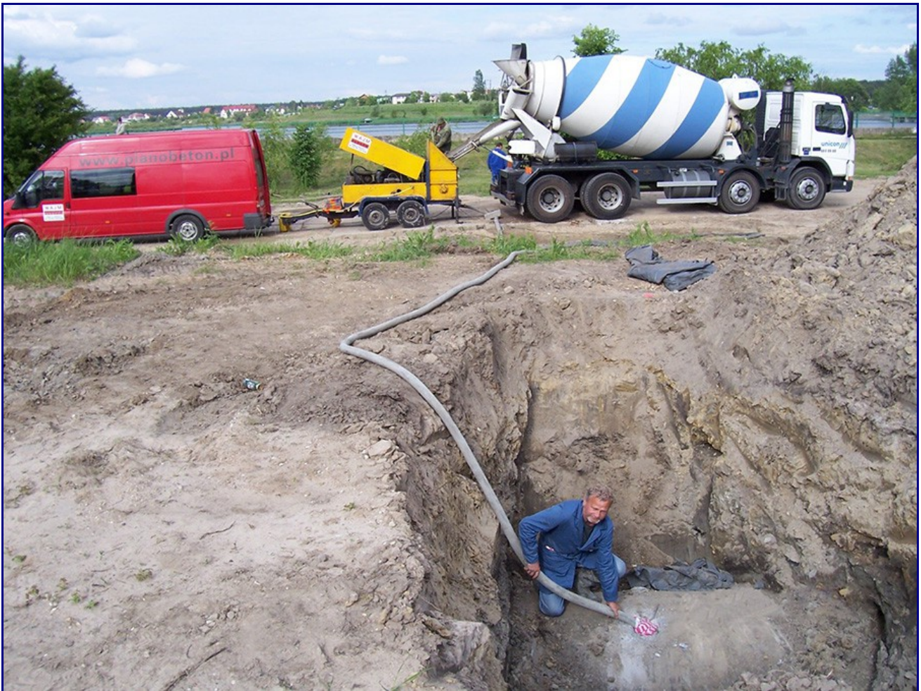
Wypełnianie nieczynnnych instalacji PB 600
