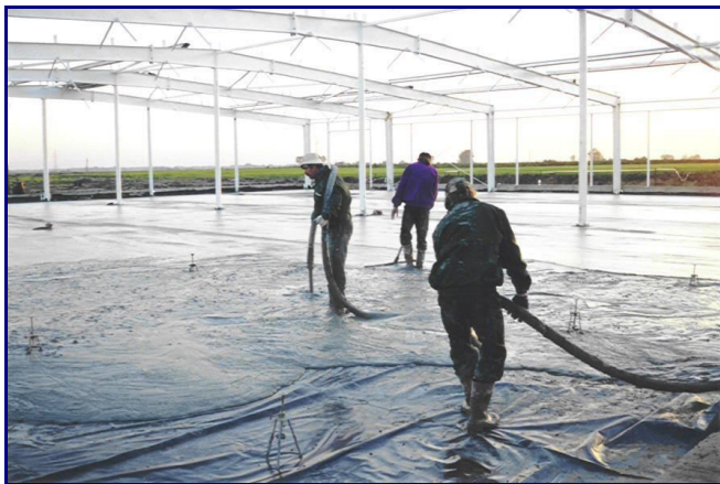
fot. 2. Wykonanie podłoża pod posadzki z PB 600
