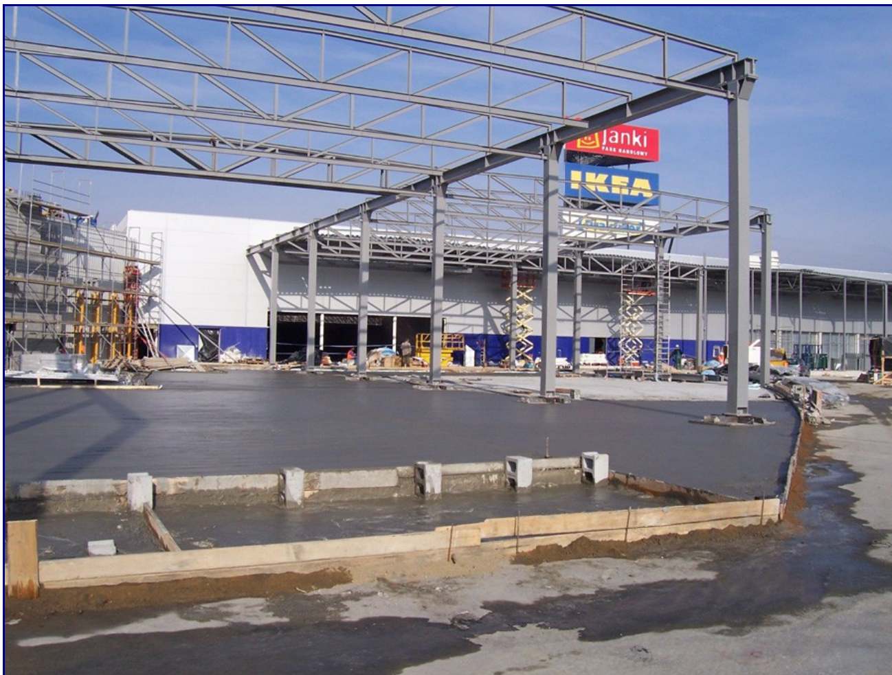
Podłoże posadzki obiektu handlowego
