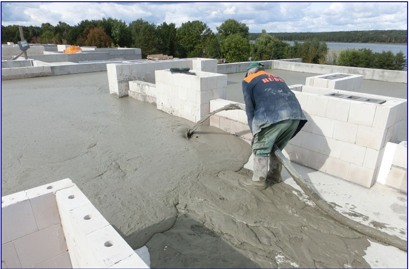
Kształtowanie stropodachu z lekkiego pianobetonu PB 500
