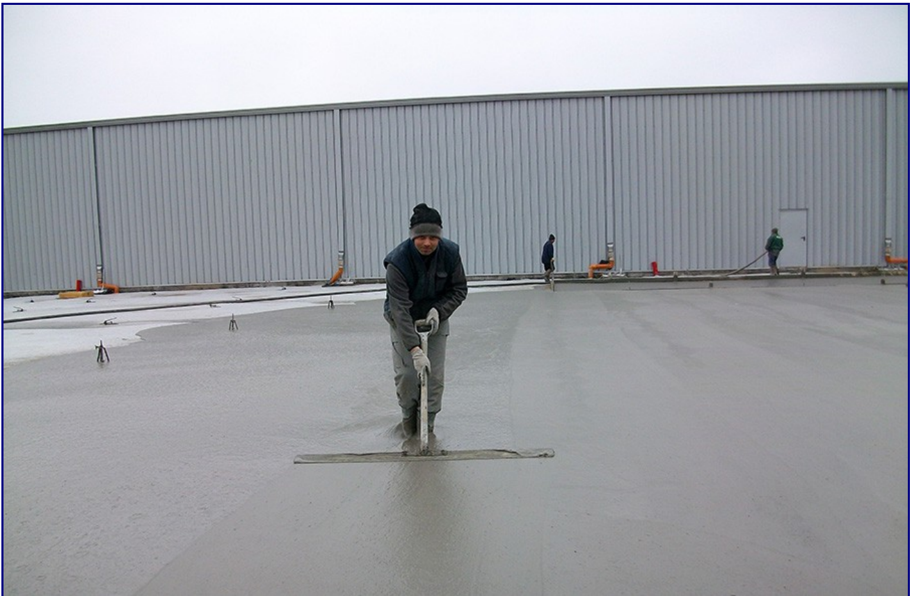
Podłoże pod posadzki w magazynie wysokiego składowania
