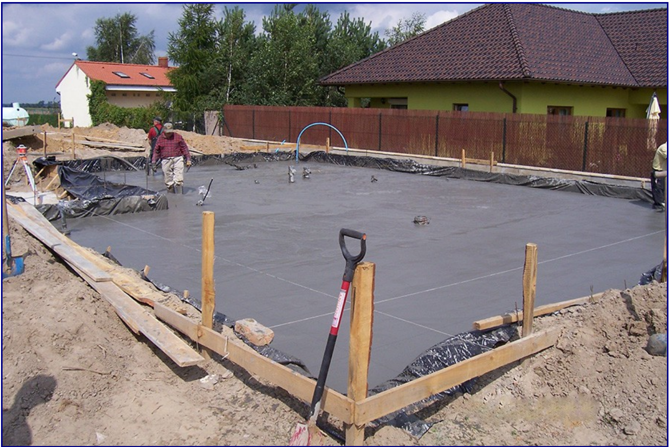
Fundament płytowy domu jednorodzinnego
