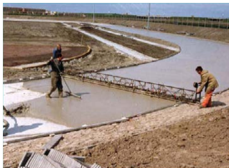
Fot. 2. Zastosowanie pianobetonu w konstrukcji bieżni [16]
